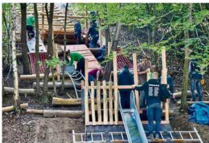
Die Attraktion des umgestalteten Sport- und Erlebniscamps bei Harbshausen: der in den Hang gebaute 20 Meter lange „Ninja-Warrior-Parkour“. Überall wurde fleißig gesägt, gebohrt und gehämmert.
